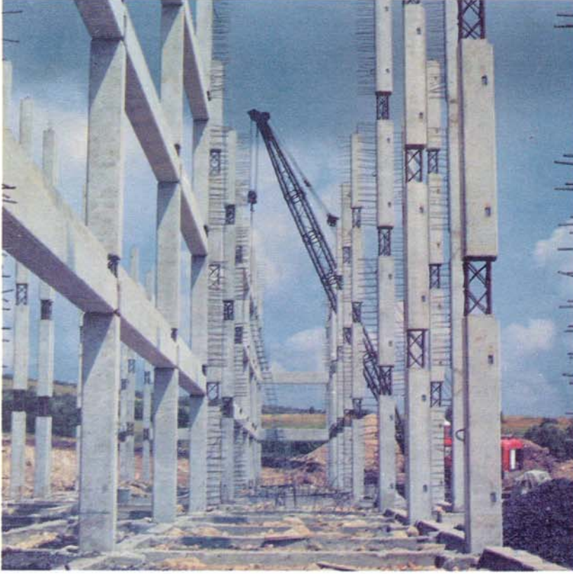
Genç Deprem Konutları İnşaatından Bir Görüntü
