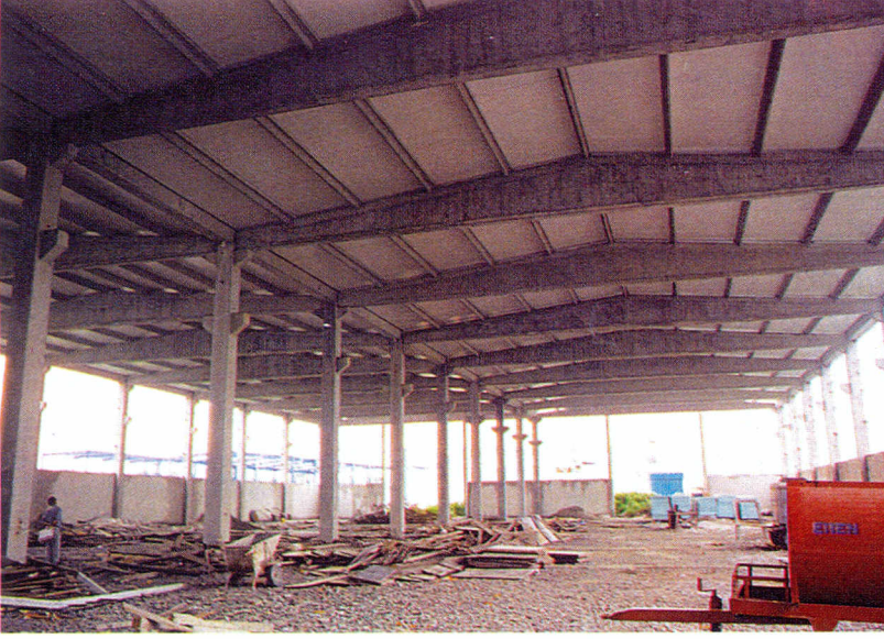
Fotoğraf 5 Adapazarı Organize Sanayi Bölgesi Hasarsız Yapı Örneği
