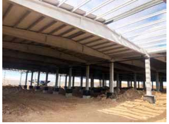
Şekil 38. Malatya 1. O.S.B., Çatı Paneli Tamamlanmış ve Tamamlanmamış Bölümler
