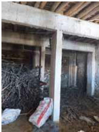
Şekil 6. Gökçe Köyü 2 Katlı Ev, Giriş Katında Niteliksiz Betonarme Çerçeve
