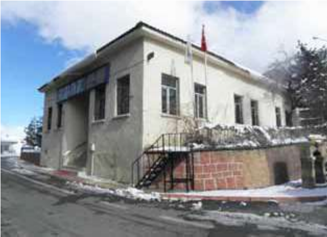
Şekil 14. Pütürge, Halk Eğitim Merkezi, Hasarsız Yığma Bina
