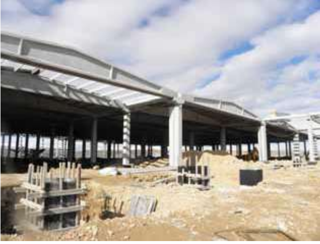
Şekil 37. Malatya 1. O.S.B., Yapım Aşamasındaki Bir Bina, Genel Görünüş
