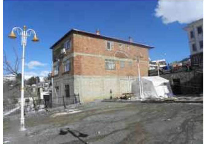
Şekil 15. Doğan yol, Hasarsız Yığma Bina
