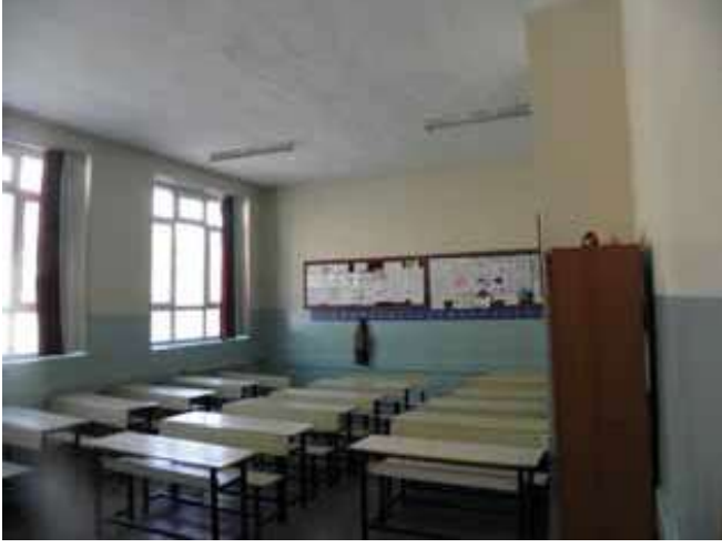
Şekil 18. Elazığ-Merkez, Hasarsız Yığıma Bina (Atatürk İlköğretim Okulu, Yapım Yılı-1937)
