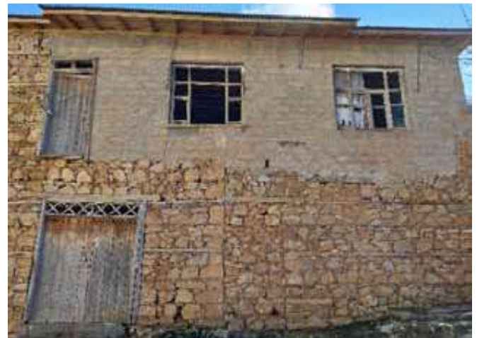
Şekil 3. Örmeli Köyü 2 Katlı Hasarsız Yığma Ev, Taş ve Ahşap Hatıllardan Oluşan Duvarlar
