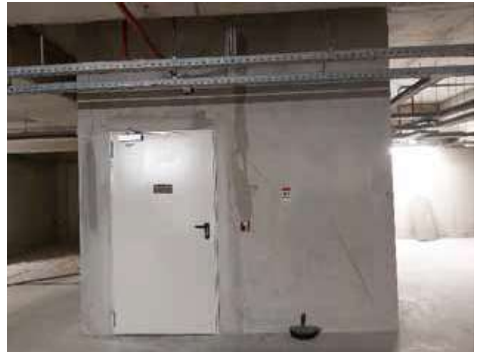
Şekil 47. İzolasyon Katındaki Taşıyıcı Olmayan Duvar
