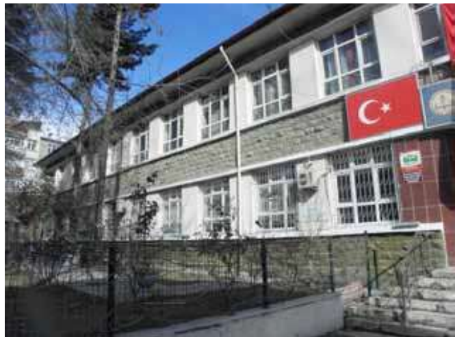
Şekil 17. Elazığ-Merkez, Hasarsız Yığma Bina (Atatürk İlköğretim Okulu, Yapım Yılı-1937)
