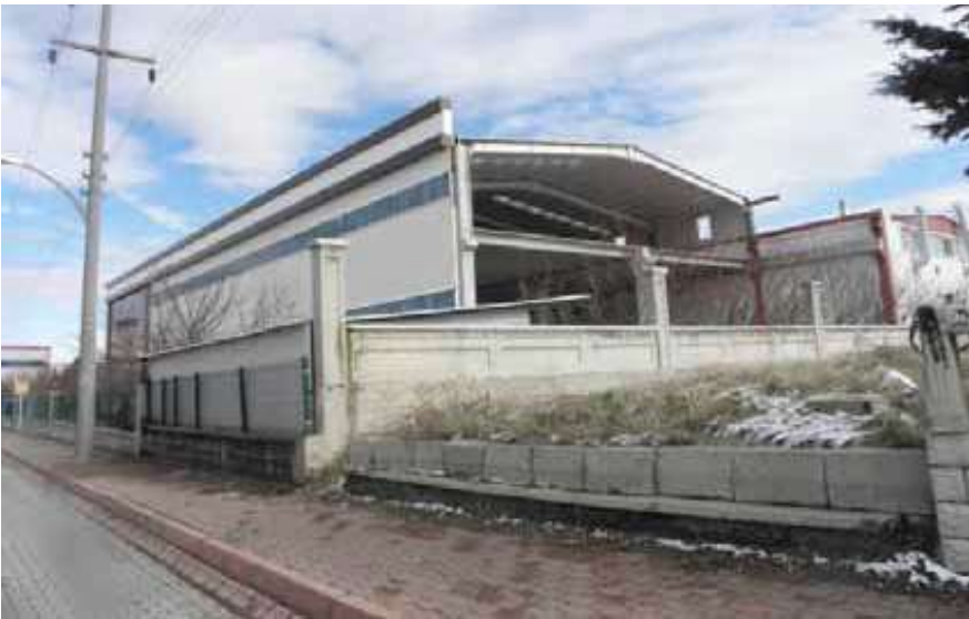
Şekil 41. Malatya 1. O.S.B., Prefabrike Betonarme Kolon Elemanları ve Çelik Çatı Makas Uygulaması
