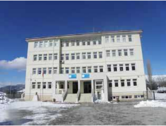
Şekil 34. Malatya, Gökçe İlkokulu (Yapım Yılı-2019) Hasarsız
