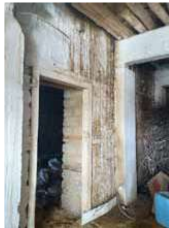
Şekil 7. Gökçe Köyü 2 Katlı Ev, Niteliksiz Betonarme Çerçeve-Duvar-Döşeme Birleşimi
