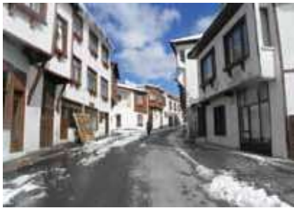
Şekil 13. Pütürge, Köylü Mah. Genel Görünüş
