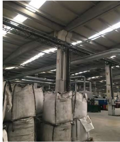
Şekil 11. Sanayi binası olarak kullanılan prefabrik betonarme sistem
