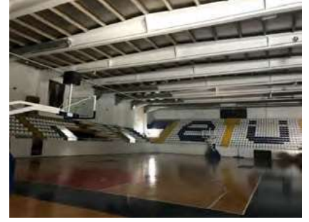
Şekil 12. Spor salonu olarak kullanılan prefabrik betonarme sistem
