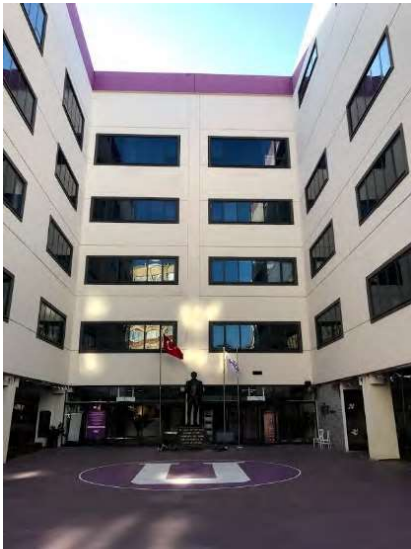
Şekil 10. Eğitim binası olarak kullanılan prefabrik betonarme sistem
