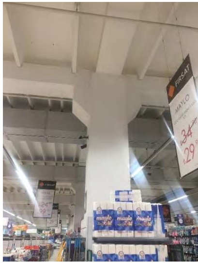
Şekil 8. Alışveriş merkezi olarak kullanılan prefabrikte betonarme sistem
