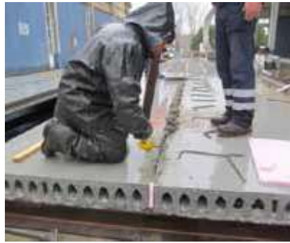
b- Aranın harçla doldurulması
