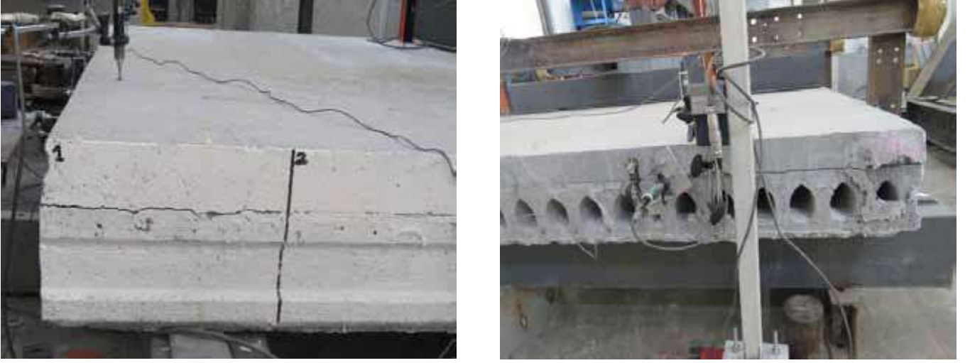
Şekil 18. Kayma donatılı numunelerde, deney öncesinde yapısal kaplama betonunun köşe bölgelerde ÖBD den ayrılması
