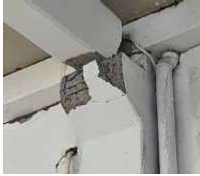
Şekil 8. Mafsallı kolon-kiriş bağlantı bölgesinde konsol ve girişte çok yaygın olarak gözlenen hasarlar
