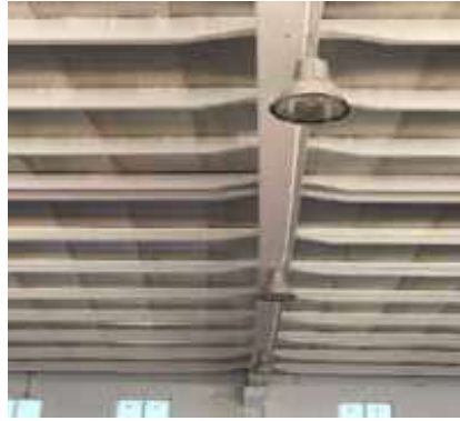
Şekil 19. Çatı kirişlerinde yetersiz üst başlık ve yanal sehim
