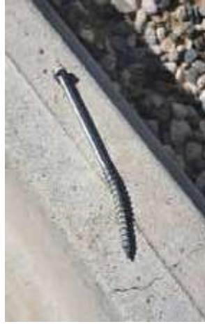
Şekil 14. Çatı örtüsünün beton aşıkla yetersiz bağlantısı ve aşık uç bağlantısında dolgu harçsız uygulama
