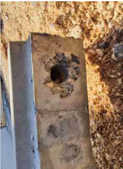
Şekil 9. Mafsallı kolon-kiriş bağlantı bölgesinde pim ve pim yuvası hataları
