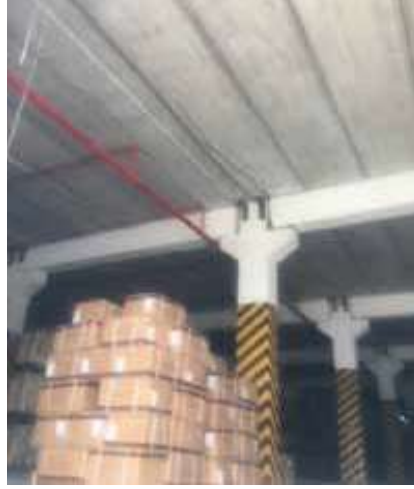
Şekil 18. Çok katlı mafsallı taşıyıcı sistemler
