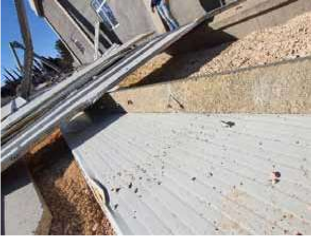
Şekil 14. Çatı örtüsünün beton aşıkla yetersiz bağlantısı ve aşık uç bağlantısında dolgu harçsız uygulama
