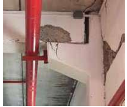
Şekil 8. Mafsallı kolon-kiriş bağlantı bölgesinde konsol ve girişte çok yaygın olarak gözlenen hasarlar
