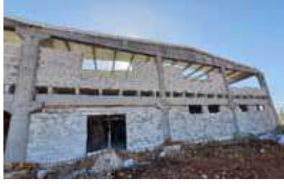
Şekil 7. Önüretimli betonarme yapım teknolojisinin kurallarını dikkate alınmadan inşa edilmiş düşük profilli bir şantiye
