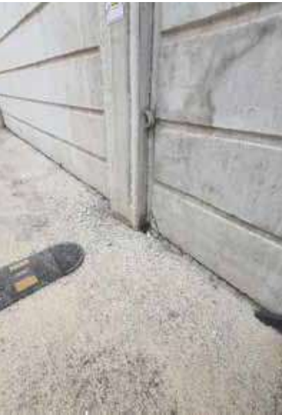
Şekil 11. Önüretimli beton cephe panelleri ve yapısal davranış etkileri
