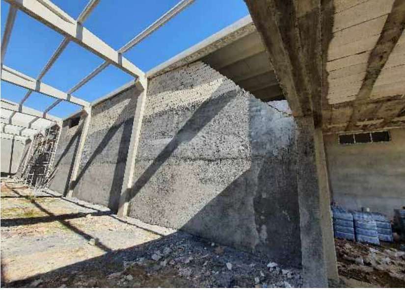
Şekil 12. Cephe duvarları ve yatay/düşey hatılların önemi
