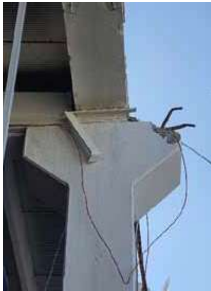
Şekil 9. Mafsallı kolon-kiriş bağlantı bölgesinde pim ve pim yuvası hataları
