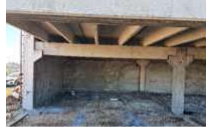
Şekil 7. Önüretimli betonarme yapım teknolojisinin kurallarını dikkate alınmadan inşa edilmiş düşük profilli bir şantiye
