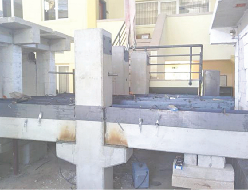
Şekil 2. Prefabrik iç kolon-kiriş bağlantı numunelerinin montaj aşaması.
