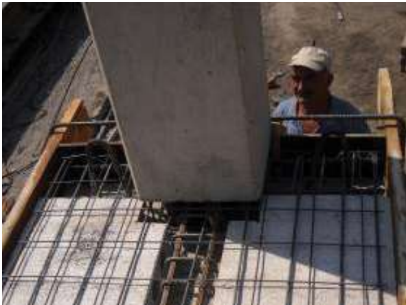
Şekil 2 b. Konut Tipi birleşimin yapım aşamaları
