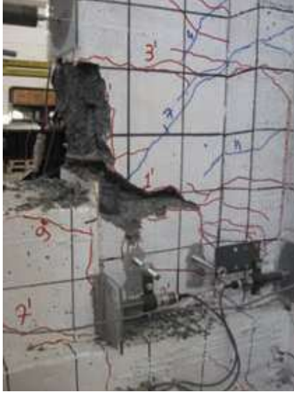
Hasarın düğüm noktası içine doğru ilerlemesi
