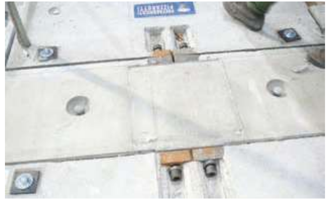
b) Alt ve üst donatılarda sürekliliğin sağlanmasına yönelik bir birleşim
