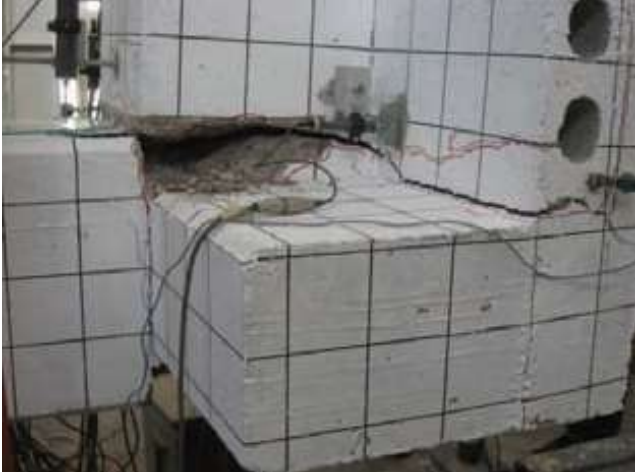
Hasarın düğüm noktası içine doğru ilerlemesi
