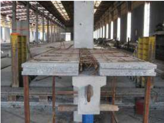
Şekil 1 b. Endüstri Tipi birleşimin yapım aşamaları
