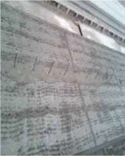
Şekil 2. Kayma donatılarının yerleşimi
