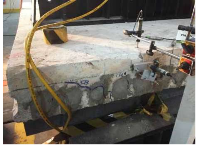
ÖBD kesitinde oluşan çatlaklar
